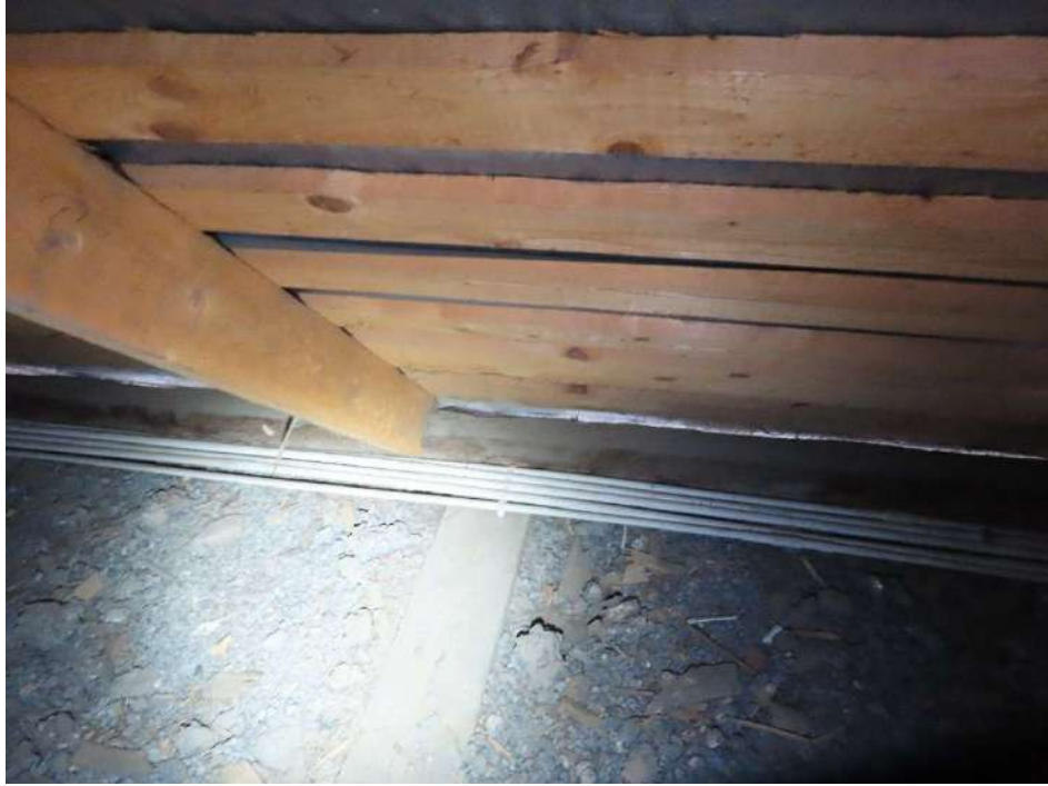
11. Stogo laikančios konstrukcijos atremtos ant viršutinio sienų vainiko.
