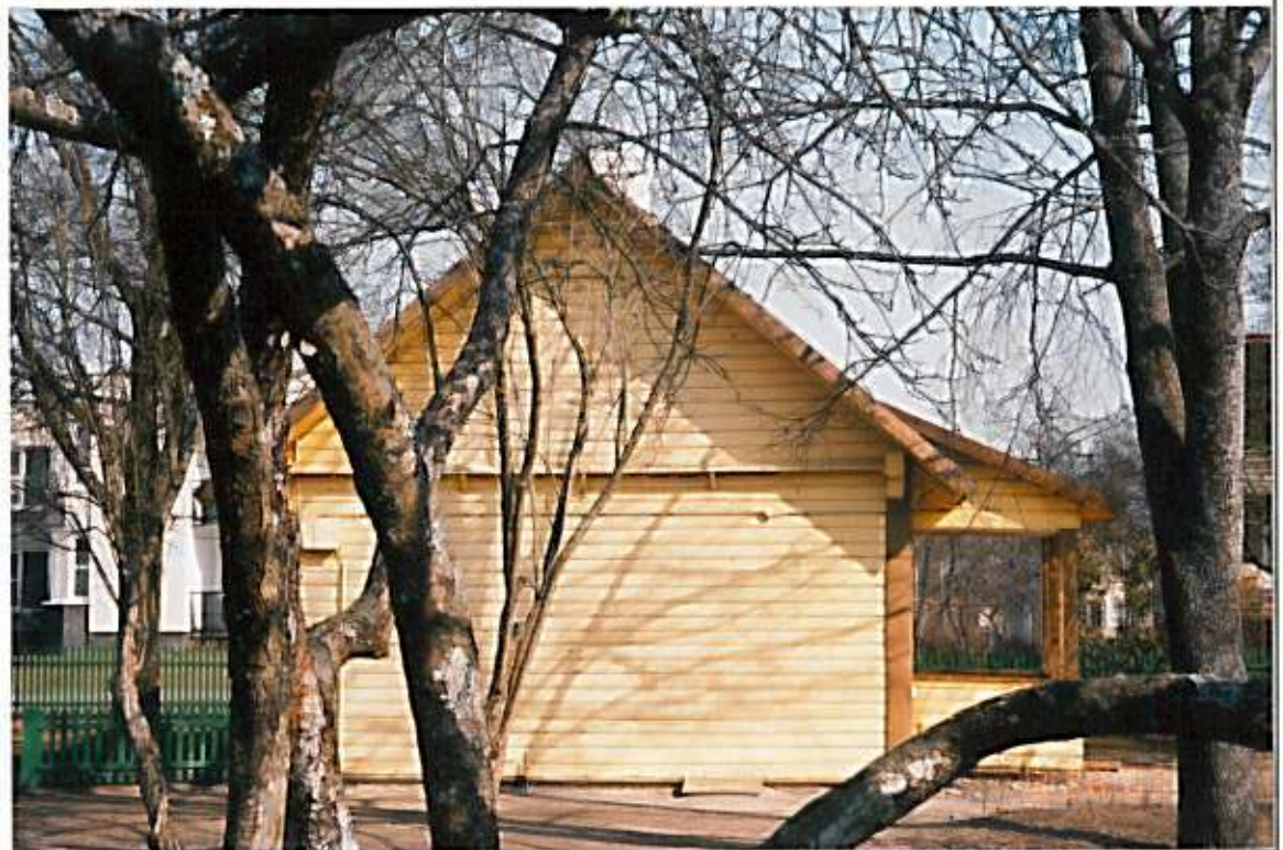
Nr. 2 Pavadinimas P. namo fasadas
